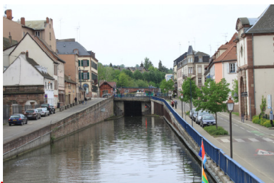
Schleuse in Saverne
